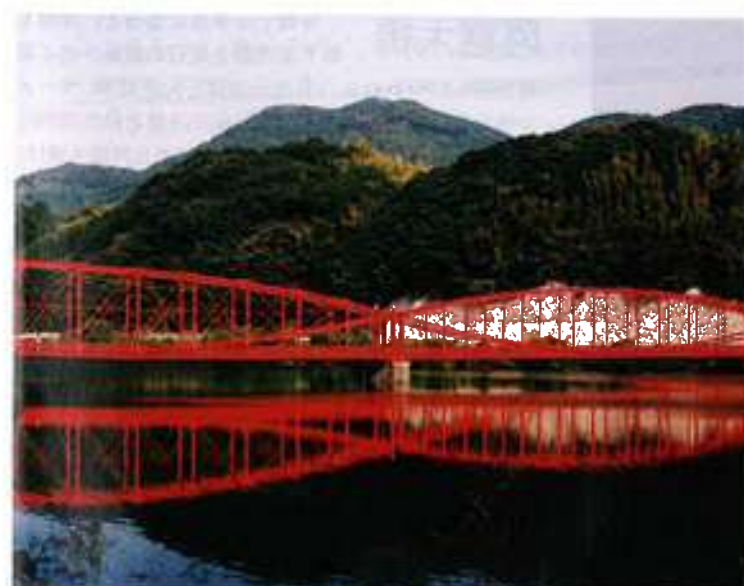
福岡県北九州市 鋼レンティキュラートラス橋（ピン結合）1926年 L=133.2m (66.6m) 【河内貯水池】
