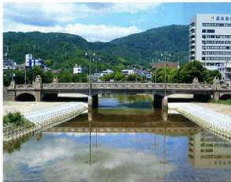
広島県呉市 RCゲルバー桁橋 1932年 L=54.0m (21.0m) 【二河川】
