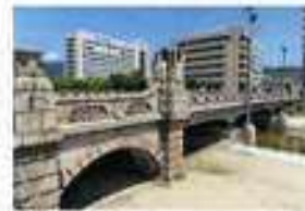
広島県呉市 RCゲルバー桁橋 1932年 L=54.0m (21.0m) 【二河川】
