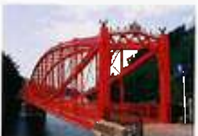
福岡県北九州市 鋼レンティキュラートラス橋（ピン結合）1926年 L=133.2m (66.6m) 【河内貯水池】
