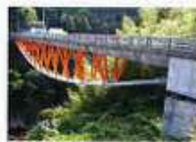
徳島県三好市 自碇式PC複合トラス橋 2004年 L=97.0m 【伊予川】
