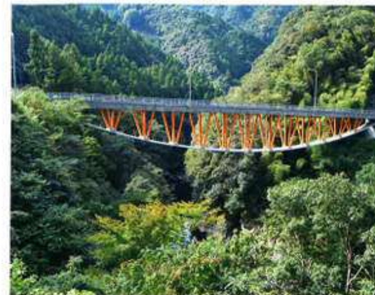
徳島県三好市 自碇式PC複合トラス橋 2004年 L=97.0m 【伊予川】
