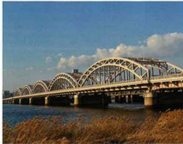
大阪市北区・淀川区 鋼プレストリブタイドアーチ橋 1932年 L=681.2m (64.0m) 【淀川】
