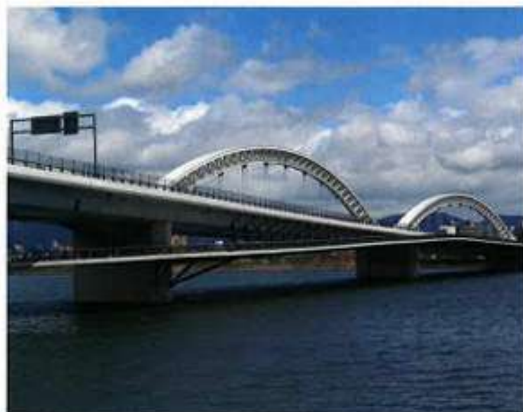
広島県広島市 鋼コンクリート複合アーチ橋 2014年 L=412.5m (116.0m) 【太田川放水路】
