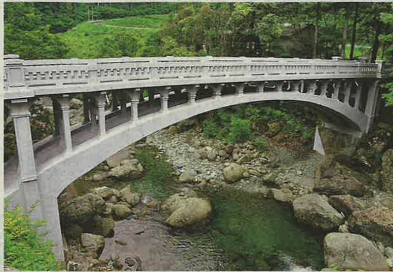
西条市の修復事業が2020年度全建賞に輝いた大宮橋。15日午後、西条市西之川
