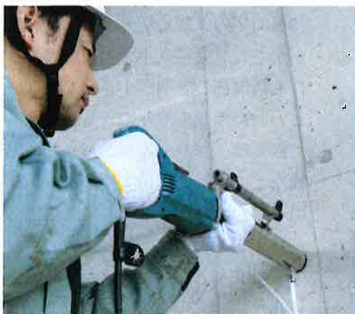
図1 ■ IPH工法の施工手順
