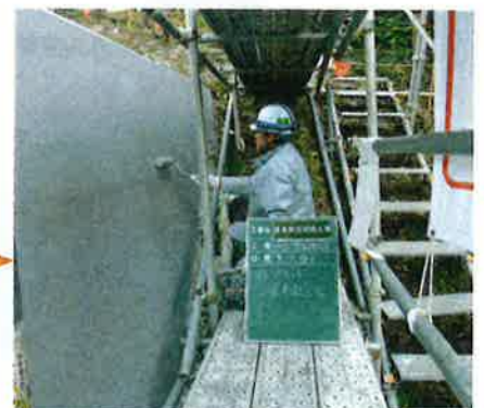
注入孔をポリマーセメントモルタルで埋めて、周囲を研磨した後、堤体の表面に無機系の通気型はっ水塗料を塗布する
