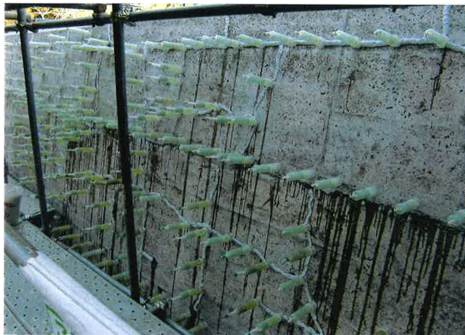
「IPHカプセル」と呼ぶ注入器を使って、エポキシ樹脂を注入。加圧状態で樹脂が硬化するまで16時間以上養生する
